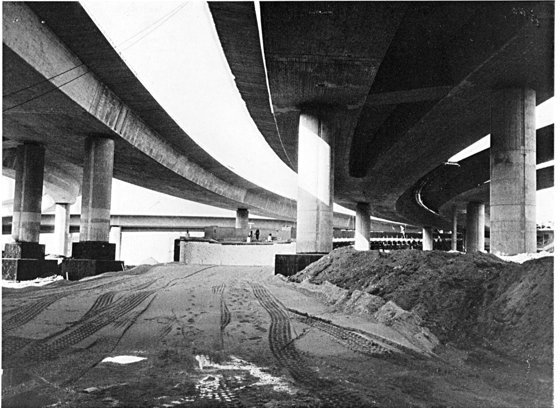
Linksrheinischer Brückenkopf · Trägeruntersicht
