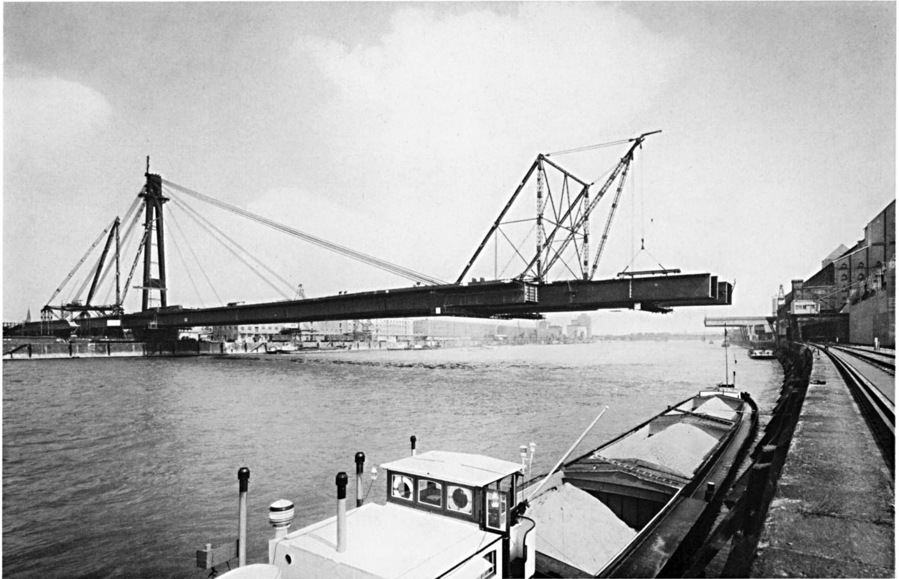
Strombrücke · Vor Auflegen auf linksrheinisches Widerlager ▷
