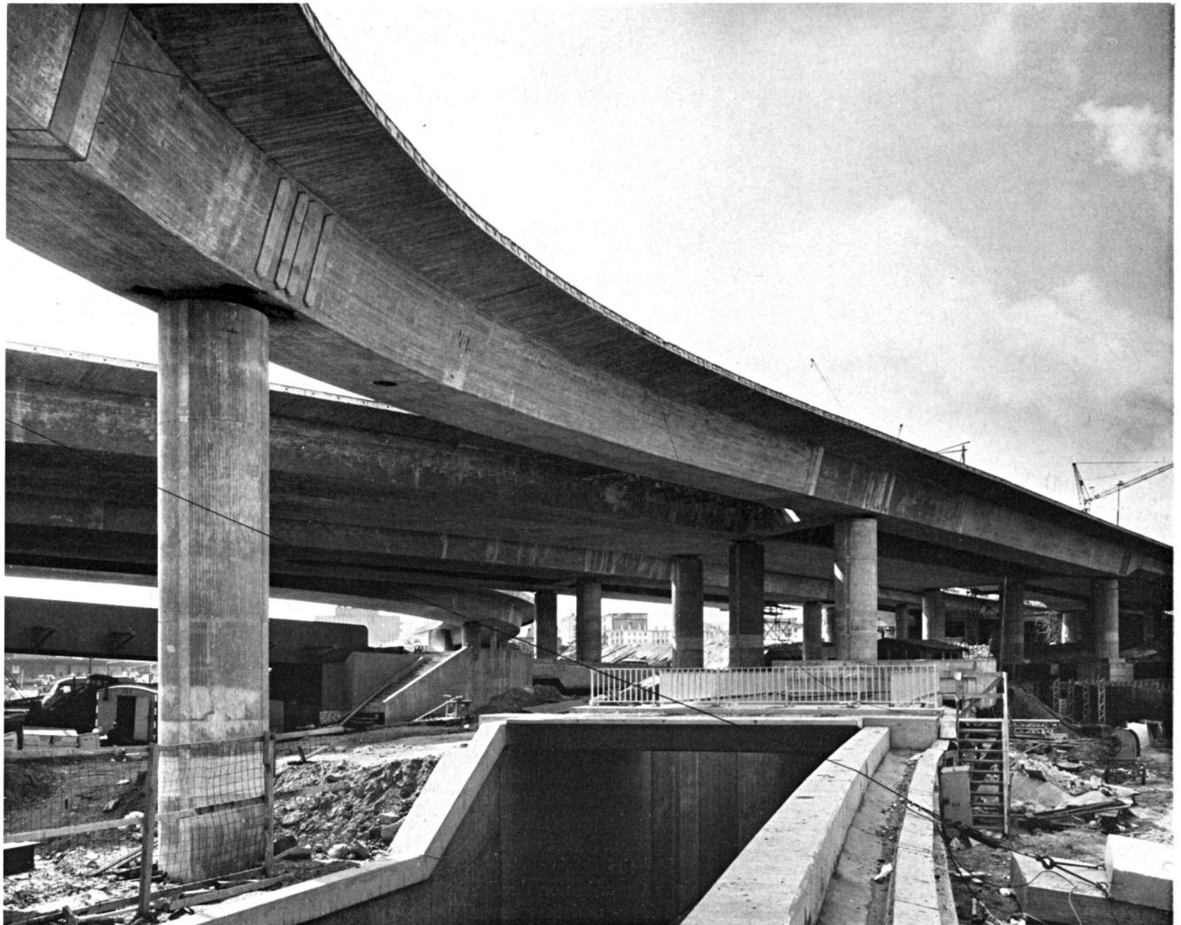
Linksrheinischer Brückenkopf · Brückenäste überqueren Tunnel
