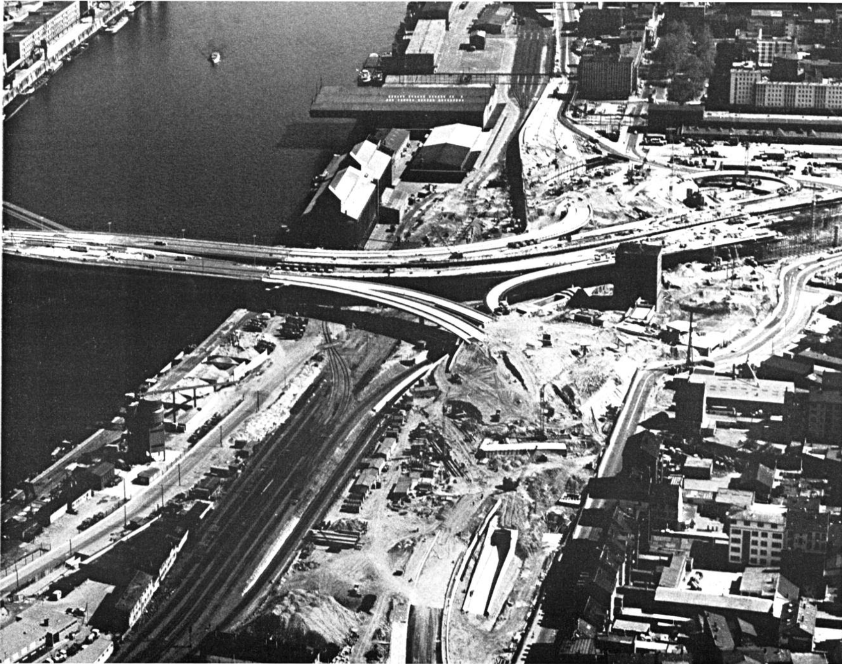
Linksrheinischer Brückenkopf im Bau
