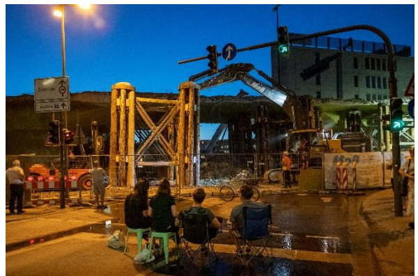
Bild 5: Eindrucksvoll: Besonders in den Abendstunden lockt die Baustelle Zuschauer*innen an.
