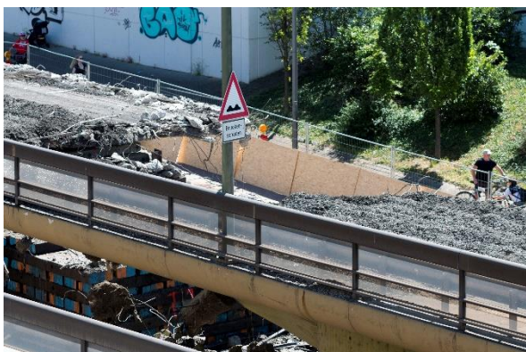
Bild 3: Fortschritt: Als zweiter, großer Teil wird auch das Bauwerk 168 dem Erdboden gleichgemacht. Dieser Teil der Hochstraße Süd führt entlang der Dammstraße am Platanenhain.
