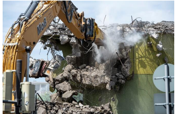
Bild 8: Abgetrennt: Damit während des Abbruchs durch die Knabberwerkzeuge keine Kräfte, Stöße und Bewegungen auf die Nachbarbauwerke übertragen werden, war im Vorfeld eine Trennung der einzelnen Bauwerke erforderlich.
