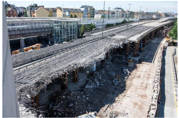
Bild 4: Gewaltig: Insgesamt 30.000 Tonnen Bauschutt entstehen beim Abriss der Pilzhochstraße.
