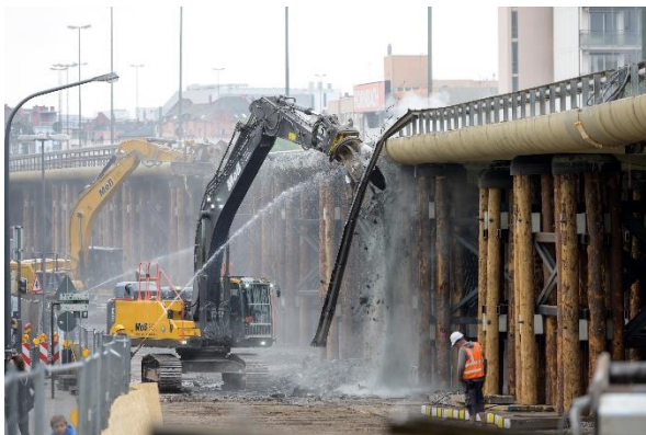
Bild 2: Umsichtig: Mit Wasser wird im Interesse der Anwohner*innen die Staub-Belastung beim Abriss reduziert.
