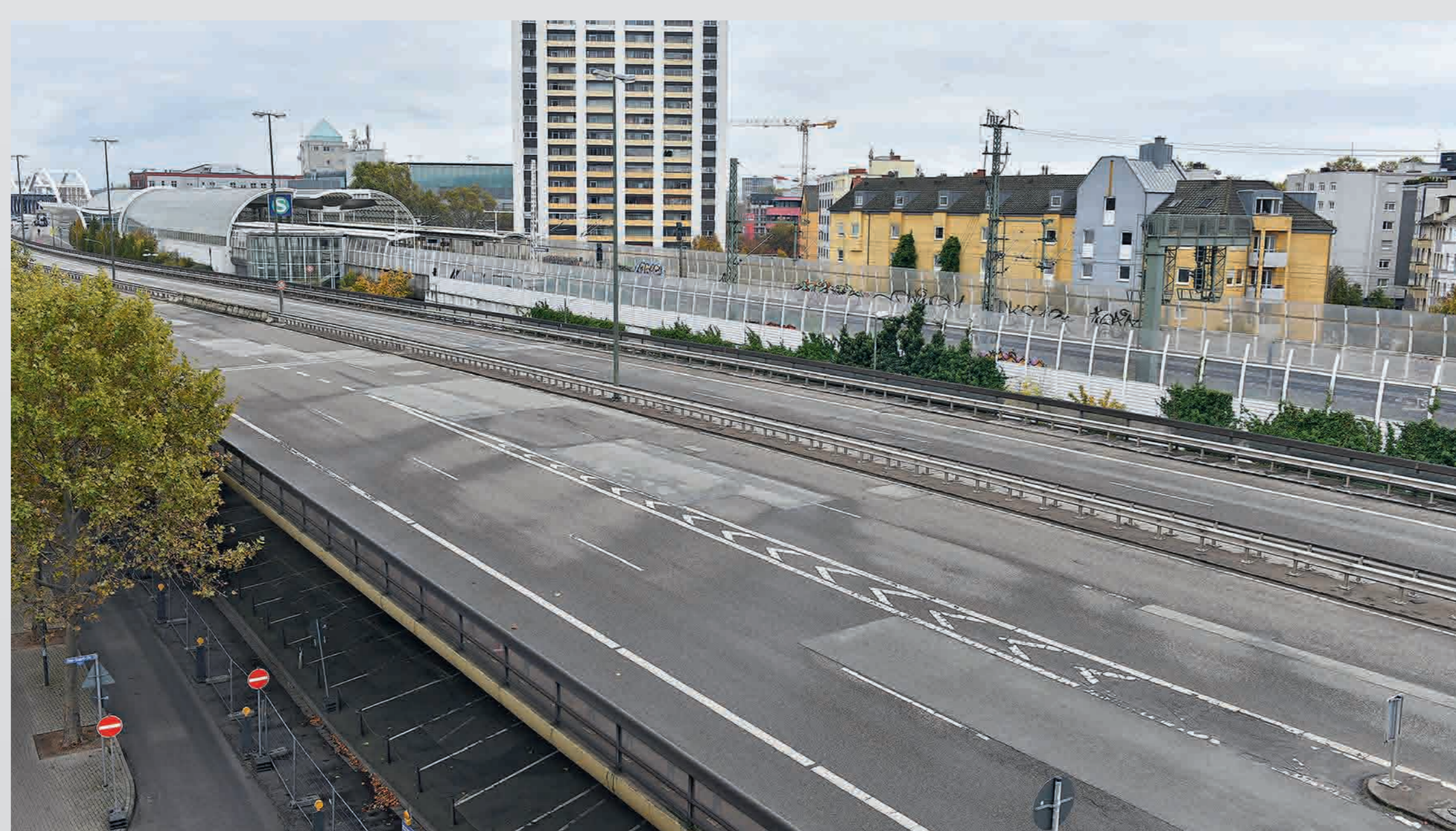
→ Die Hochstraße Süd ist für den Verkehr gesperrt.
