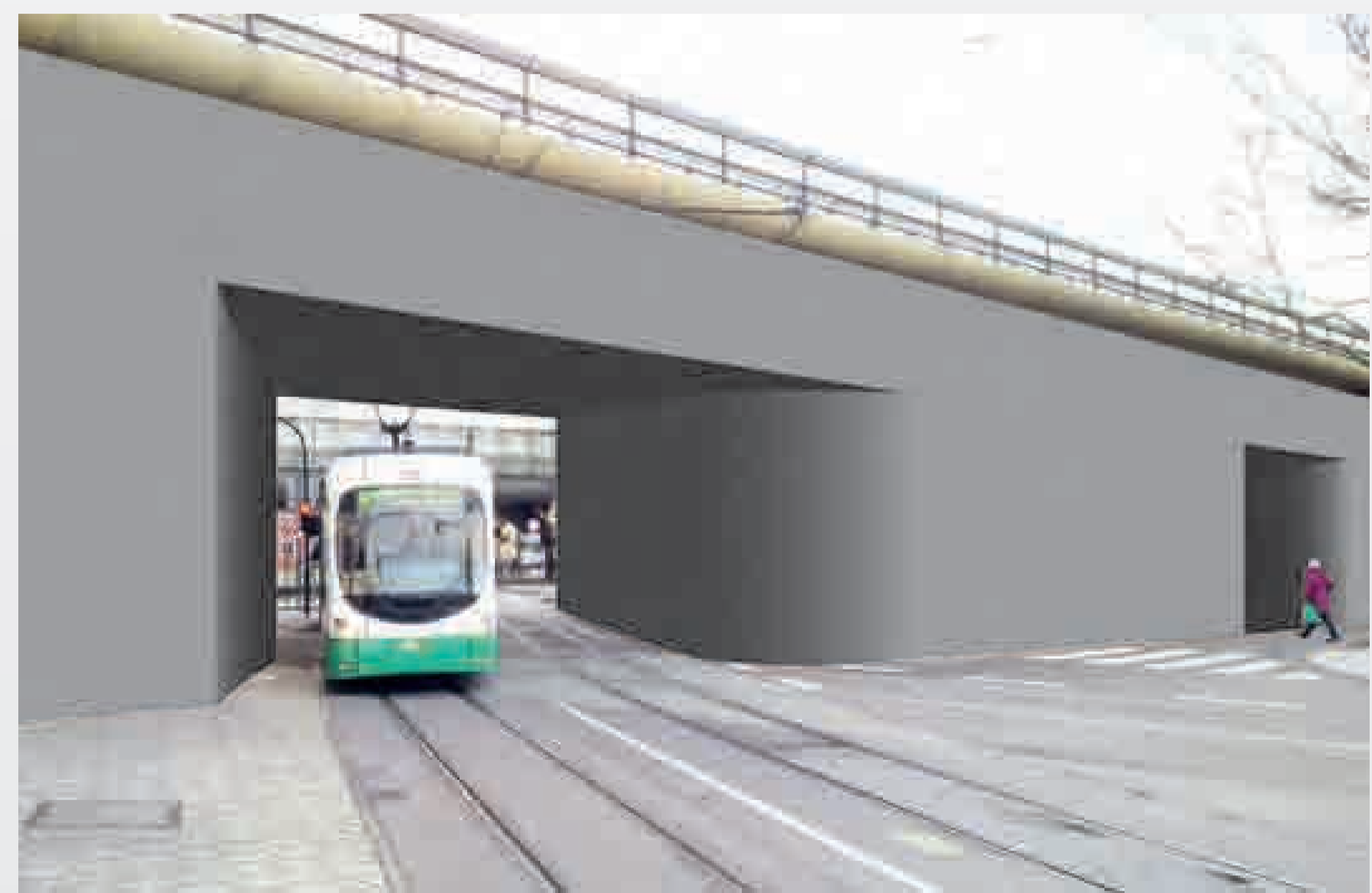
→ Das Galeriebauwerk unter der Pilzhochstraße an der Durchfahrt vom Berliner Platz zur Mundenheimer Straße ist bautechnisch schwierig.
