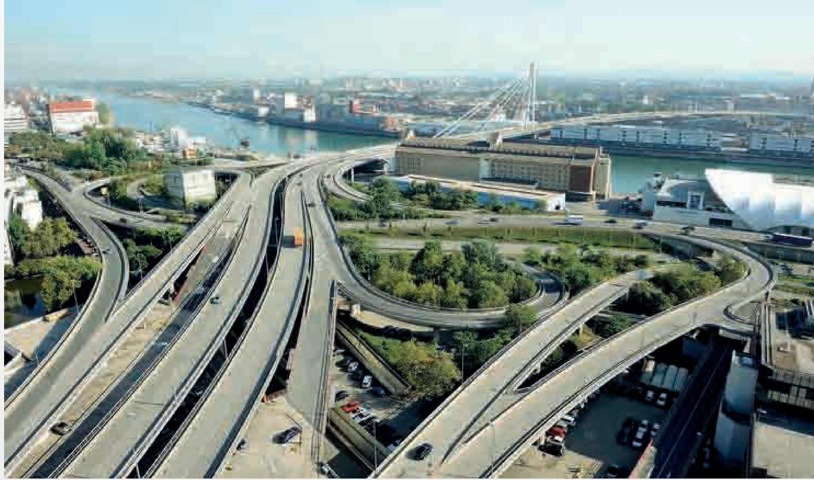
→ Das Parkdeck Rathaus-Center ist unter die Auf- und Abfahrtsrampen zur Kurt-Schumacher-Brücke geschoben und damit mit der Konstruktion der Hochstraße Nord verwoben.
