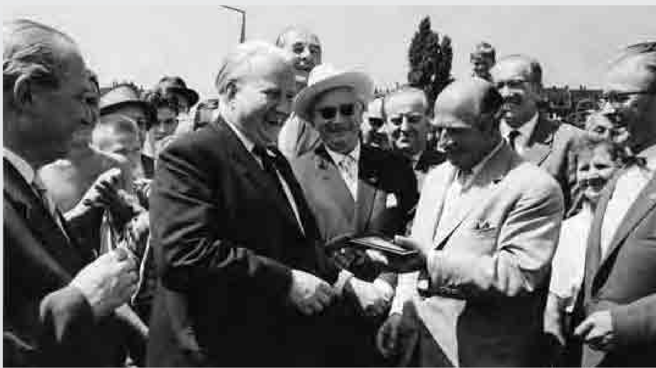
→ Die Hochstraße Süd wird am 9. Juli 1959 durch den damaligen Bundesverkehrsminister Dr. Hans-Christoph Seehofer dem Verkehr übergeben.
