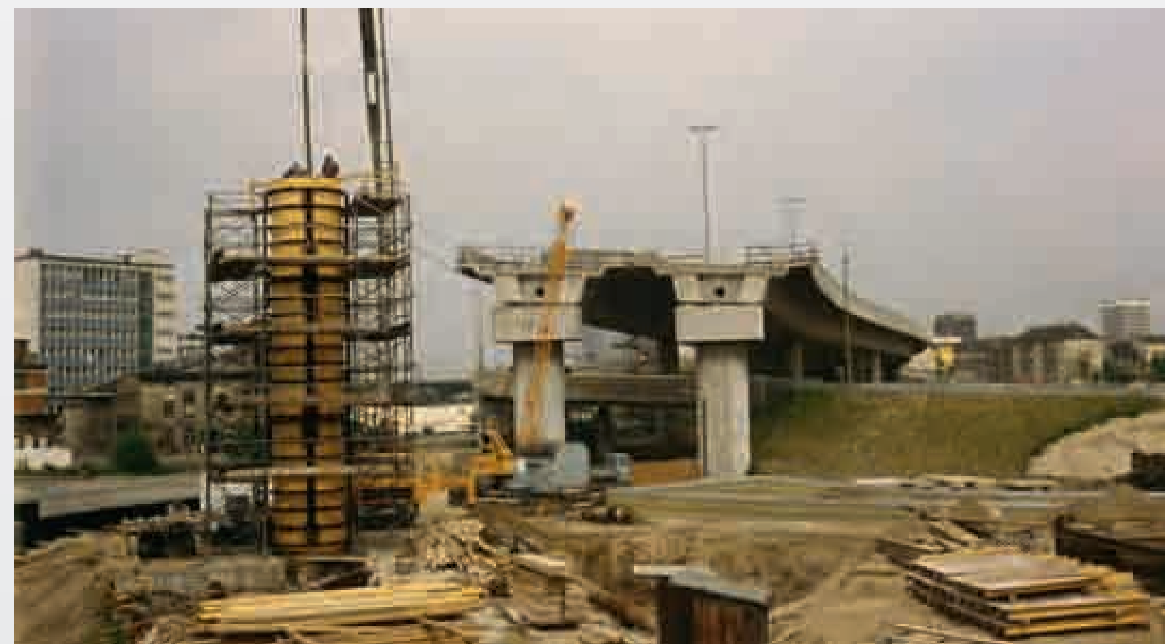
→ Bau der Hochstraße, Juni 1978
