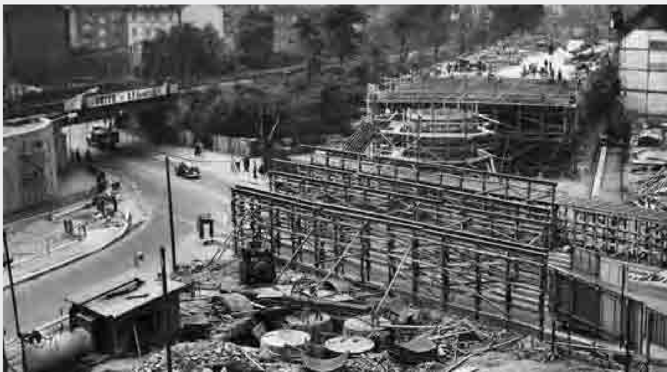
→ Im Jahr 1957 wird der Abschnitt der Pilzhochstraße am Übergang der Ludwigstraße zur Mundenheimer Straße gebaut.
