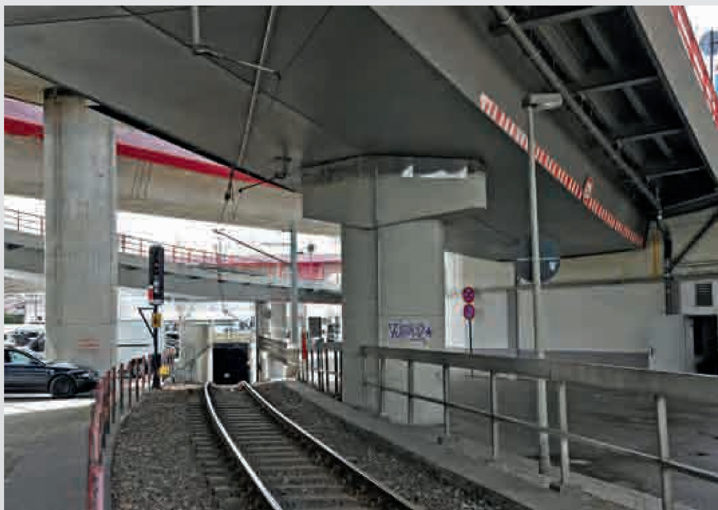
→ Die Stadtbahnstrecke unterhalb der Hochstraße Nord führt entlang der Nordmall zur Haltestelle im Untergeschoss des Rathaus-Centers.
