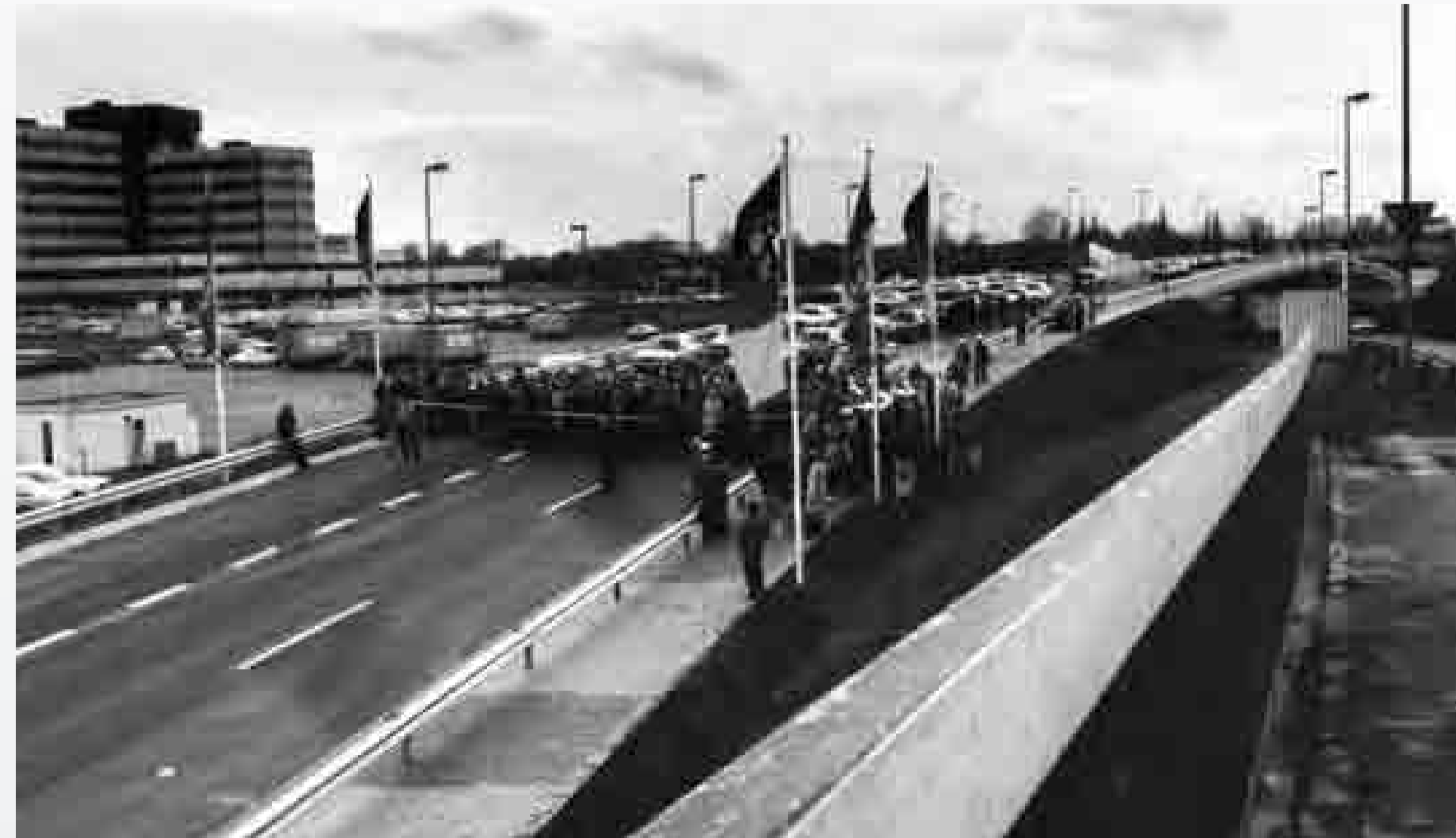
→ Übergabe eines Teilstücks der Hochstraße Nord in Höhe Postbank und Paketpostamt (Bruchwiesenstraße), 10. Dezember 1980
