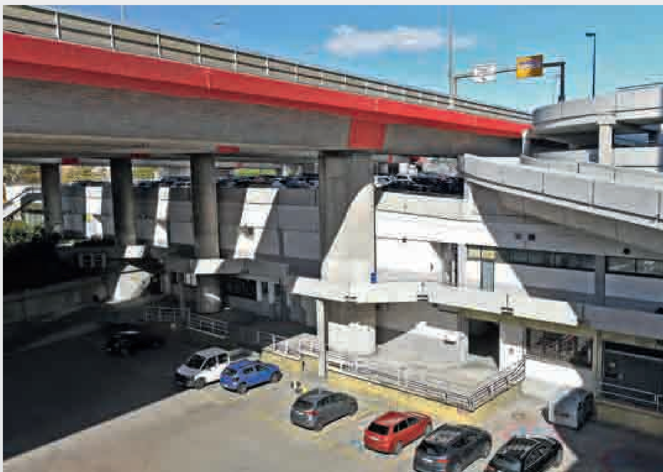
→ Hochstraße Nord und Rathaus-Center sind baulich eng miteinander verknüpft.
