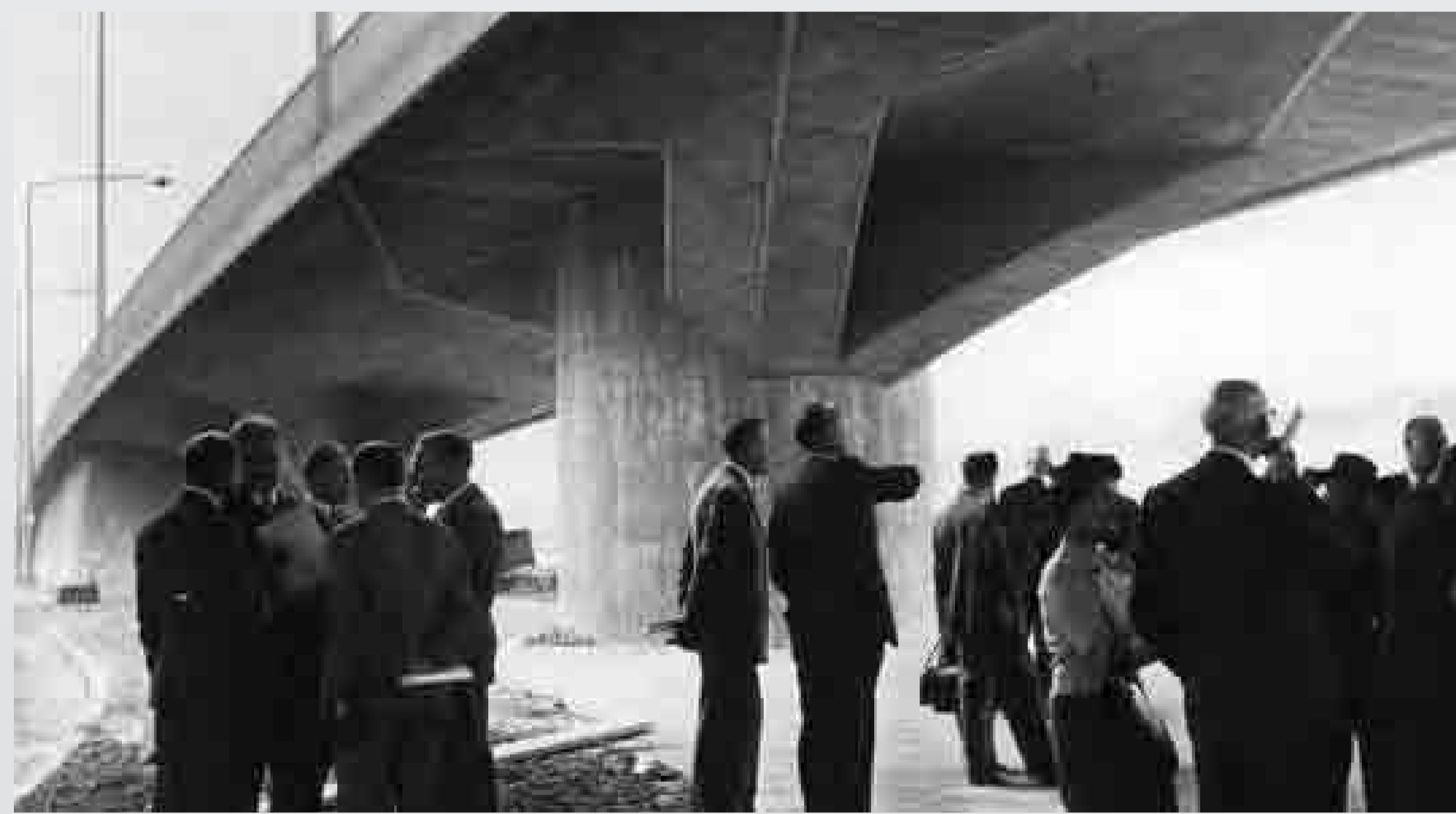
→ Britische Baufachleute besichtigen am 16. Oktober 1959 den Rheinbrückenkopf und die Hochstraße Süd.
