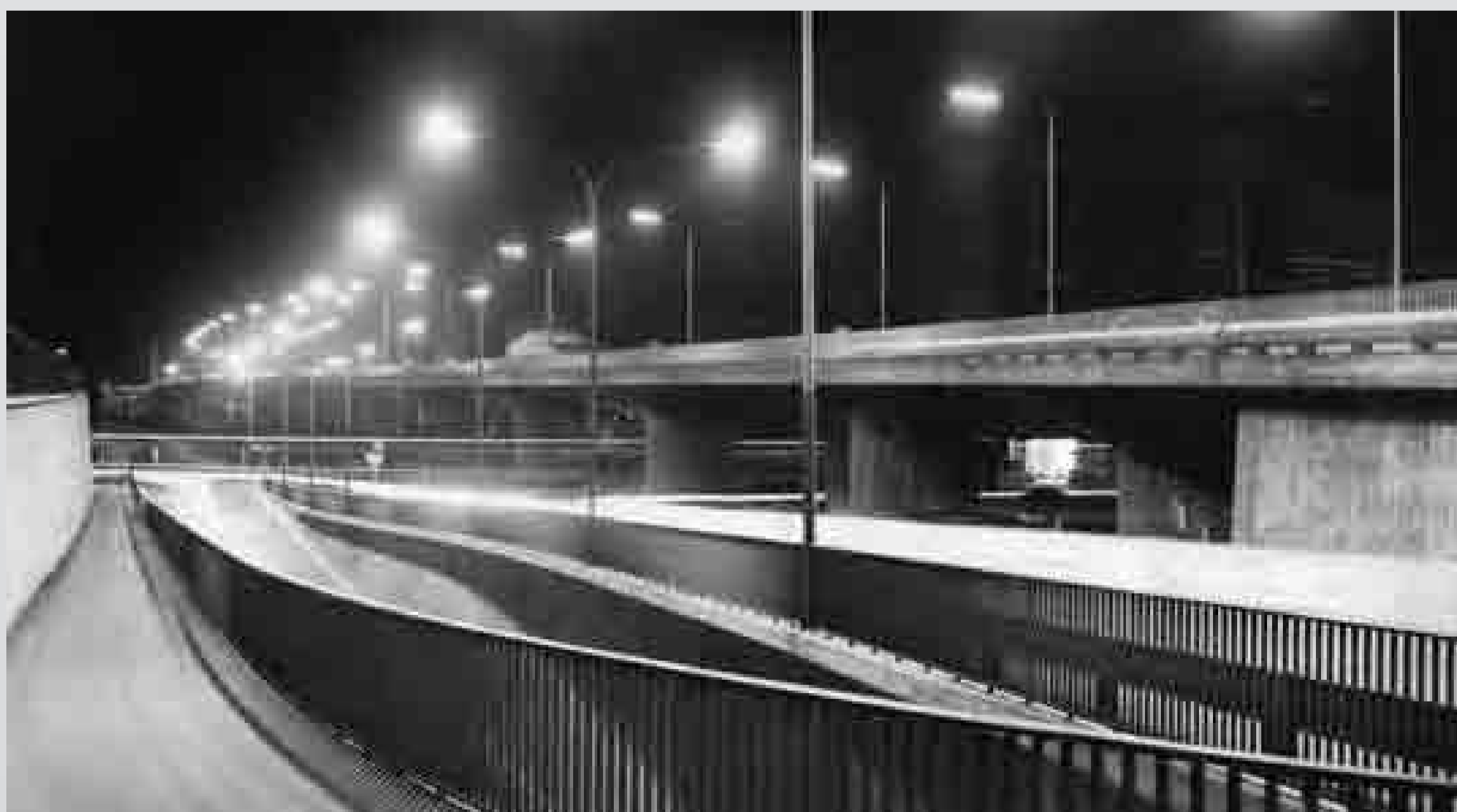
→ Kurz nach der Einweihung am 9. Juli 1959: Der Teilabschnitt der Hochstraße Süd, die Pilzhochstraße, in Blickrichtung Rhein.
