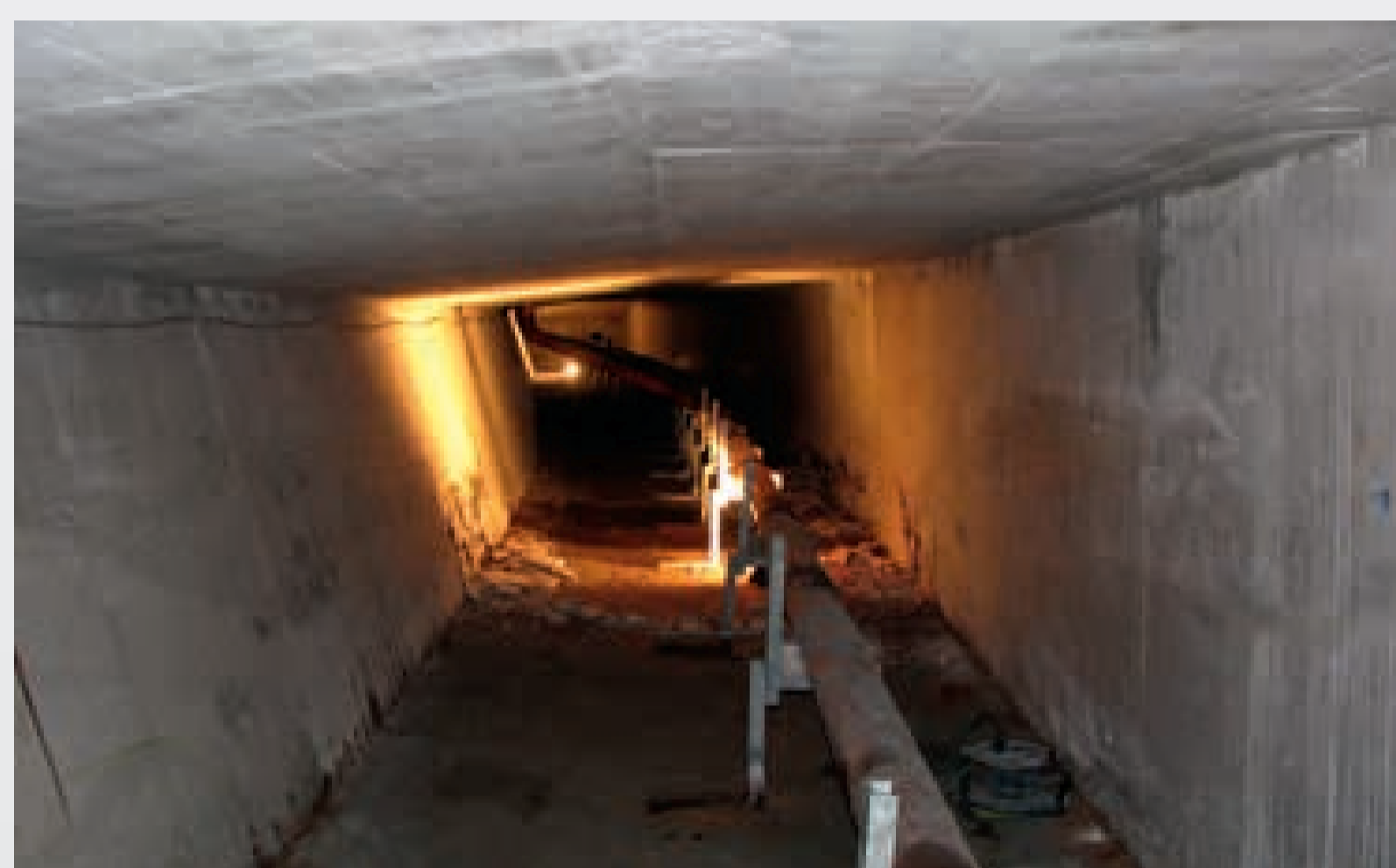
→ Blick in Hohlkasten der Hochstraße Nord.
