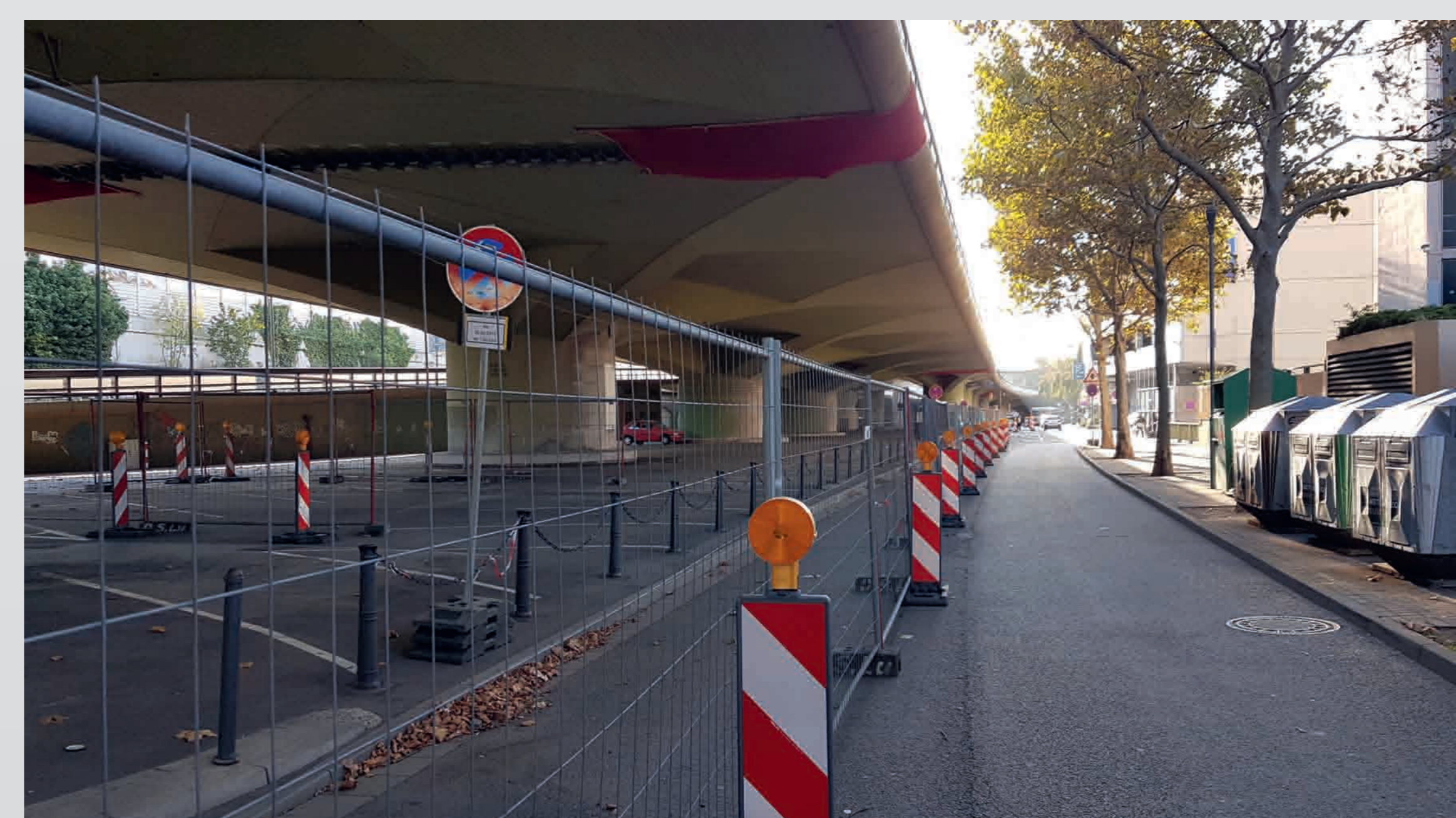
→ Aus Sicherheitsgründen sind auch die Bereiche unterhalb der Pilzhochstraße gesperrt.
