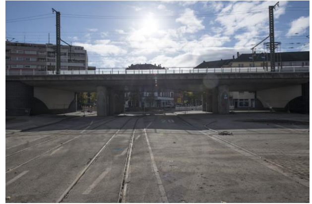
Bild 5: Die Berliner Straße soll nur wenige Wochen nach Abrissende voraussichtlich Mitte Dezember 2020 für den Verkehr wieder freigegeben werden.
