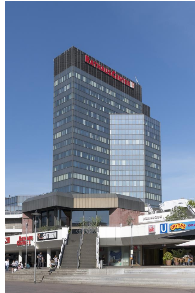
Bild 8: Das Schicksal von Rathaus und Rathaus-Center ist besiegelt: Der Komplex soll abgerissen werden.
