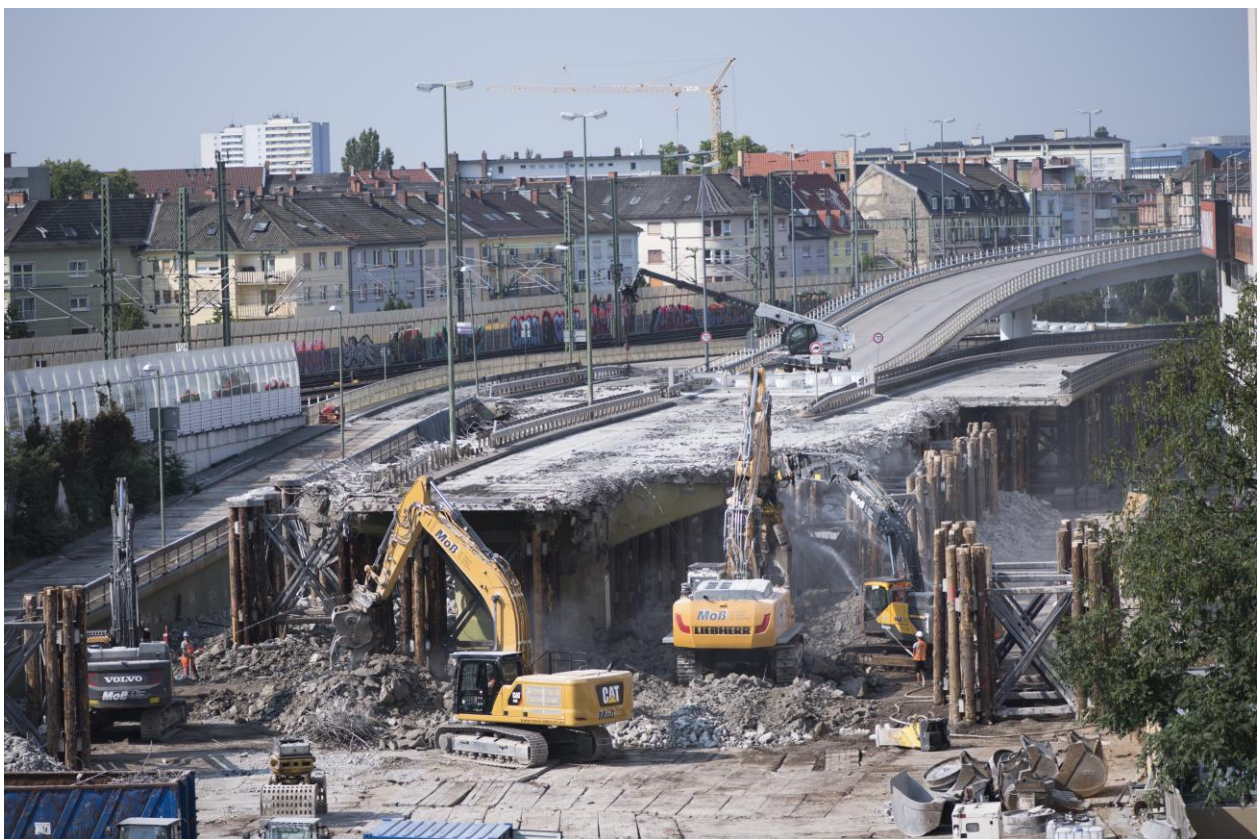
Bild 1: Zug um Zu verschwindet die Pilzhochstraße aus dem Stadtbild. Insgesamt dauert der Rückbau 210 Tage.
