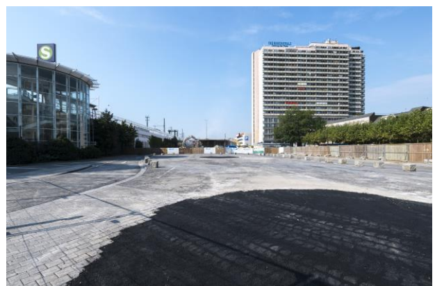
Bild 3: Mit dem Abzug der Baucontainer und Maschinen sowie dem Abtransport der letzten Baggermatratzen kann die Baustelle von der Stadtverwaltung abgenommen werden.
