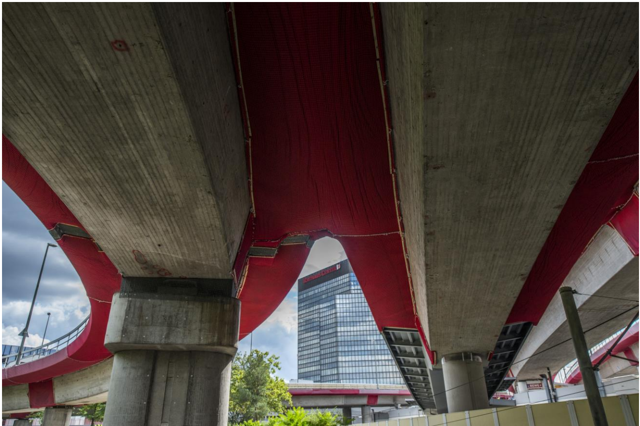
Bild 9: Eine Sanierung der Brückenabschnitte der Hochstraße Nord ist wirtschaftlich nicht möglich. Sie werden abgerissen und durch eine ebenerdige Stadtstraße ersetzt.
