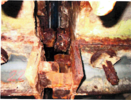
167-0_LAG QUERKRAFTKOPPLUNG MIT BLATTROSTBILDUNG
