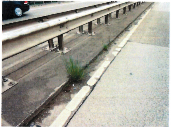
167-0_FB LÄNGSFUGE IST BEWACHSEN
