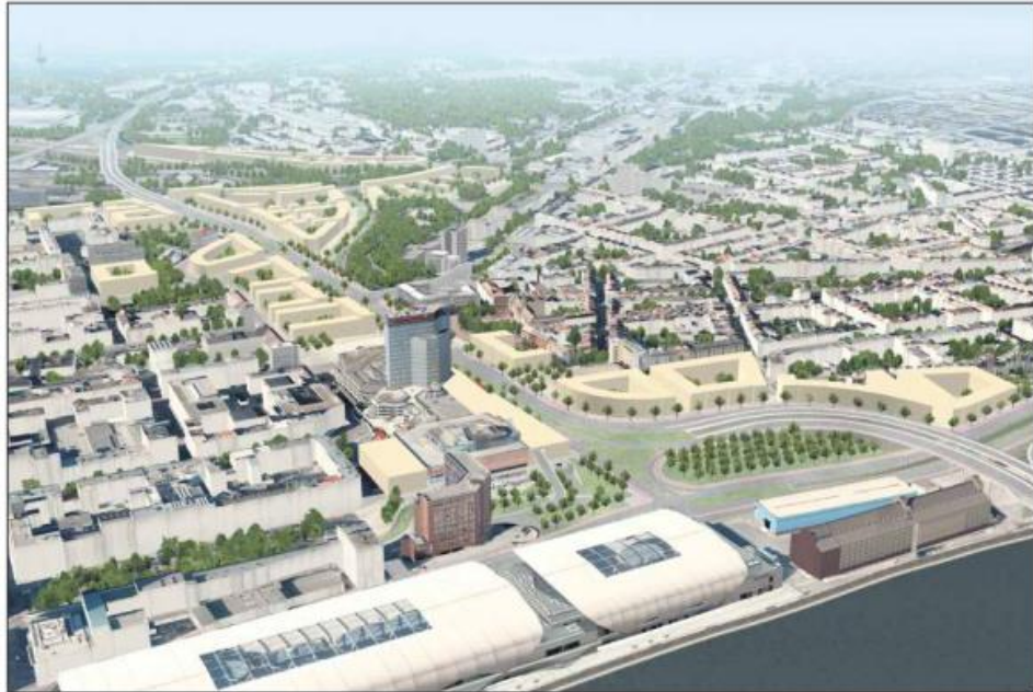
Die neue Streckenführung: Das Gewirr von Auffahrten am Nordbrückenkopf ist entflochten, ein Wäldchen auf einer Verkehrsinsel geplant. BILD: STADT
