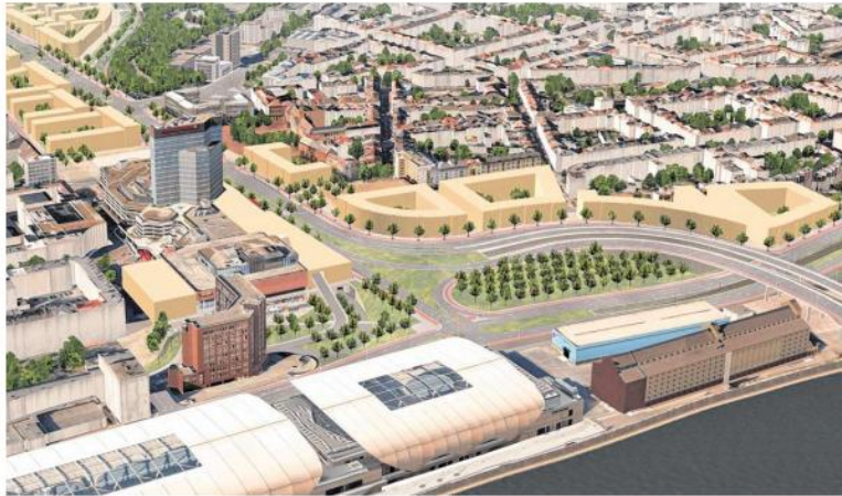
Keine engen Kurven bei der Stadtstraße mehr: Durch den Hochbunker-Abriss soll sich die Verkehrsführung am Nordbrückenkopf verbessern.
